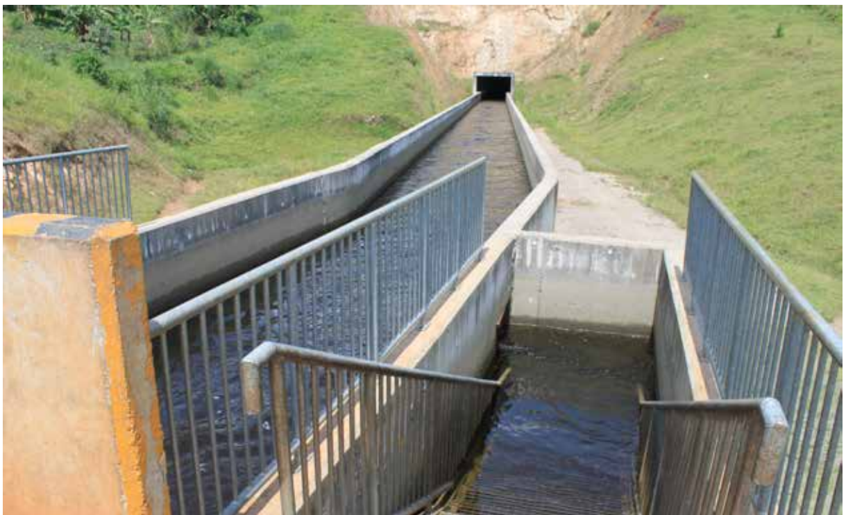
Kanalen som fører vann til kraftverket inn i tunnel, med vannpost til høyre ned trappen. FOTO: MORTEN SVELLE
