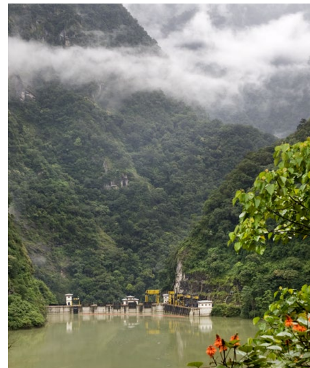
Tala dam. PHOTO: KEN OPPRANN
