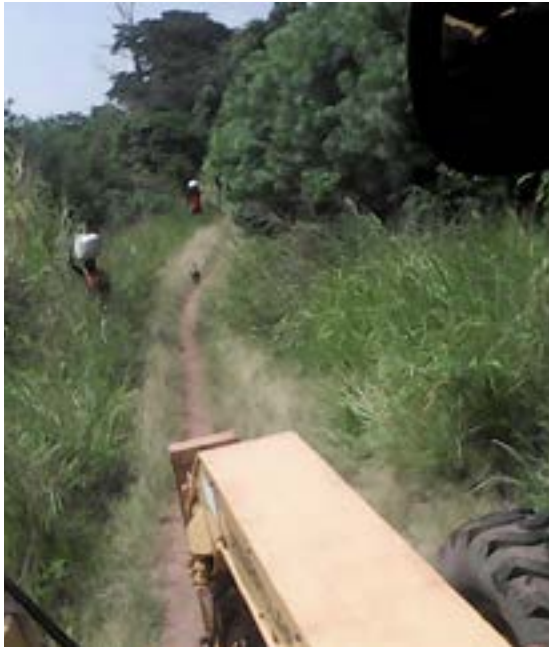
Veien før renovring. FOTO: CARITAS NEBBI
