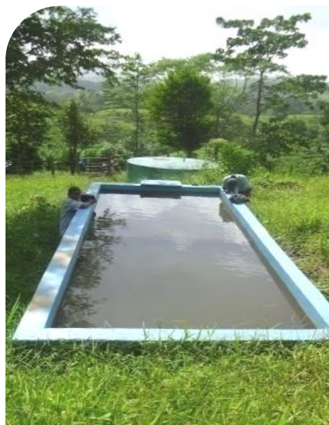
Ilustración 30: Filtro grueso aguas arriba, al fondo tanque de almacenamiento sin clorador.
