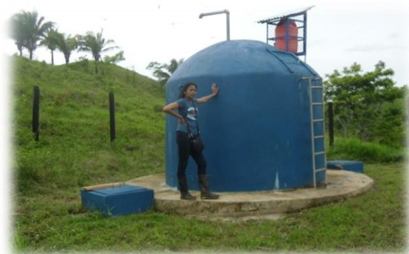
Ilustración 4: Tanque con su clorador en Tadaznita.
