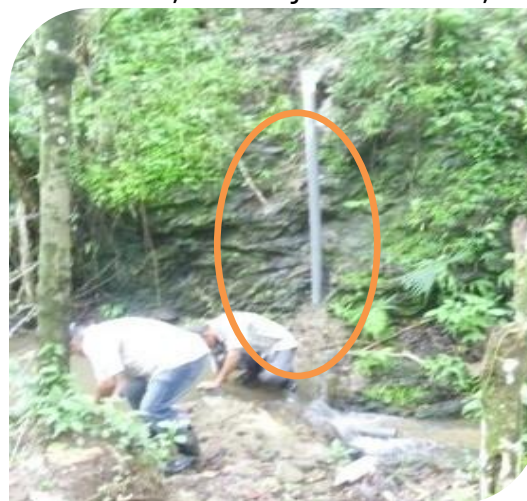
Ilustración 23: Cruce de tubería PVC expuesta en quebradas.
