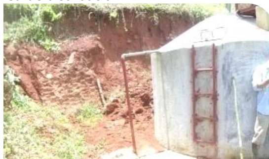
Ilustración 19: Tanque para Caño de Laja con escalera y clorador, al fondo la erosión.
