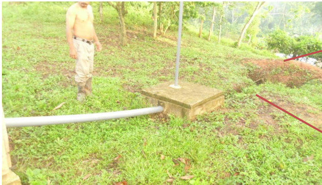
Ilustración 32: tubería de sanitario expuesta, al fondo fosa de aguas servidas.
