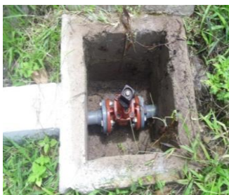
Ilustración 8: Tapón roscado PVC, sustituye válvula de compuerta en tubería de limpieza en caja de captación.
