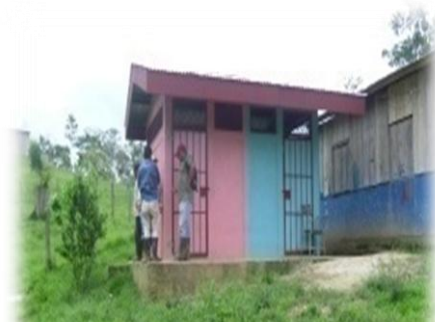
Ilustración 29: Módulo sanitario de Escuela Luz Divina, cuenta con inodoros y urinarios.
