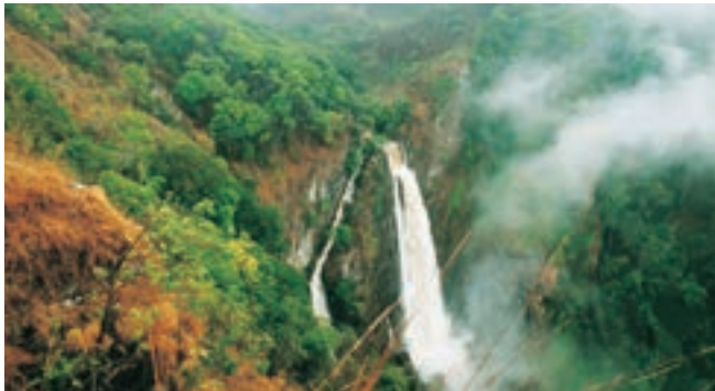
Vannkraft fra Kihansi står for 32 prosent av all vannkraft som produseres i Tanzania.
