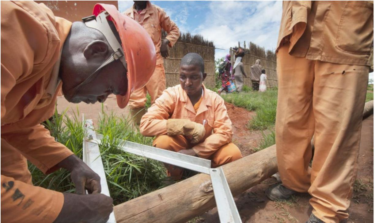
Técnicos da EDM constroem postes durante a instalação da linha de eletricidade na região norte de Moçambique. FOTO: KEN OPPRANN
