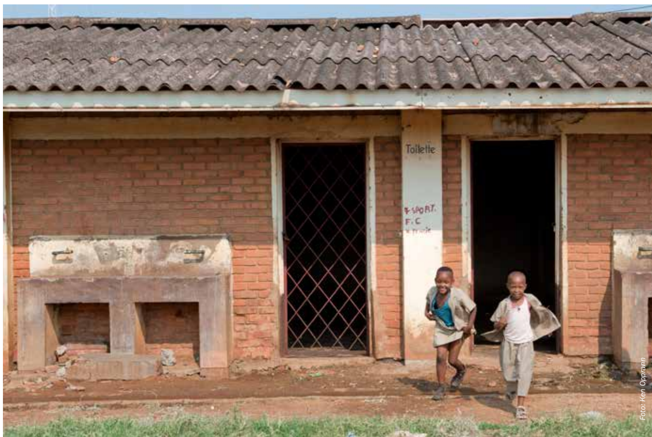
I norsk støtte til utdanning inngår ofte bygging av atskilte latriner for jenter og gutter. Av burundiske jenter i skolealder går 95 prosent på skolen. Bildet er fra Jabe 1-skolen i Burundis hovedstad Bujumbura.
