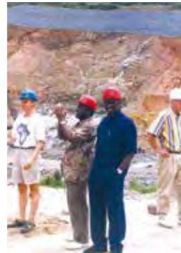
Eneo la ujenzi wa Bwawa la Kihansi. Kushoto ni Jan Lindermark (Mshauri wa Norplan), Buruany Luhanga (Mkurugenzi wa TANESCO), Patrick Rutabanzibwa (Kamishna wa Nishati). Picha: Even Sund (1998).
