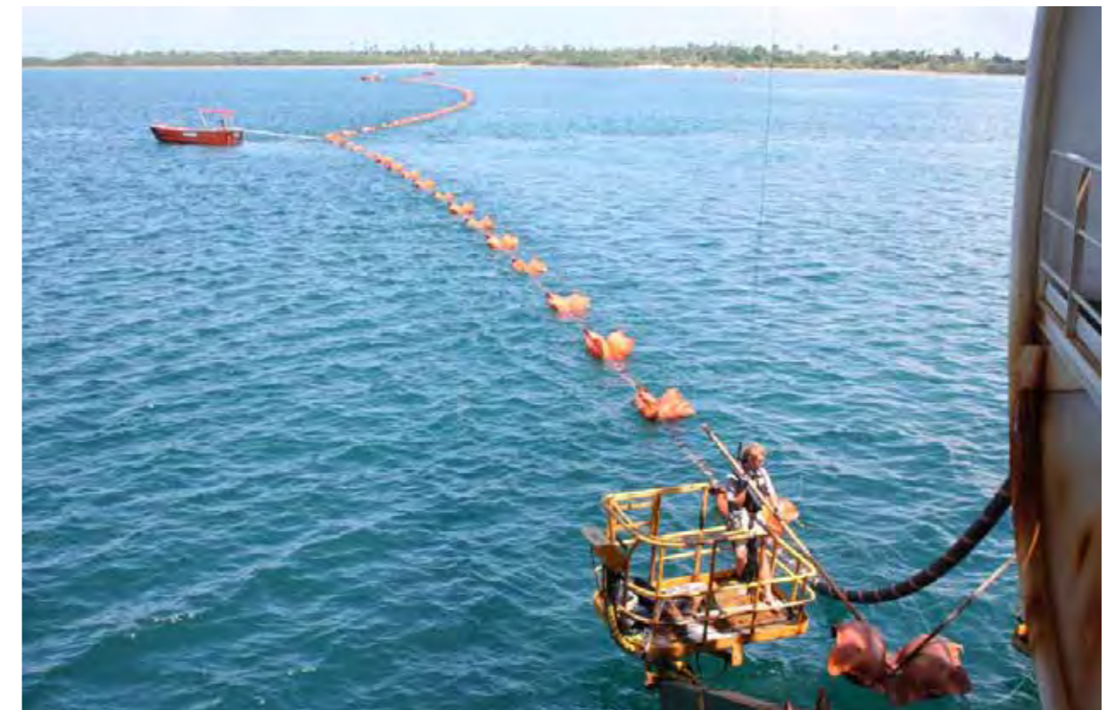
Mkongo wa chini ya bahari ukiwa umefikishwa nchikavu Pemba. Kina cha bahari kinatofautiana sana wakati wa kupwa na kujaa kwa maji, jambo linalomaanisha kuwa kazi ilipaswa ipangiliwe na itekelezwe kwa ustadi mkubwa. Picha: John Alvsvåg (2009)
