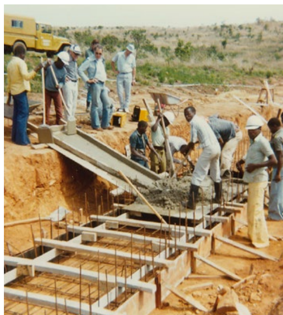
Ingeniører fra EDM og norske eksperter på befaring i forbindelse med byggingen av småkraftverket Lichinga i nordlige Mosambik tidlig på 80-tallet. FOTO: NORAD ARKIV
